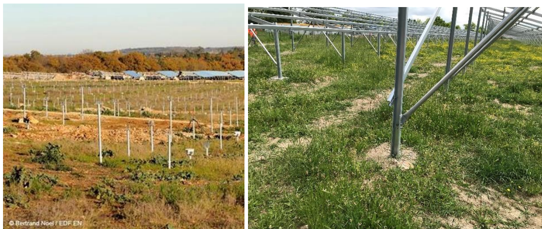
Figure 6 : Fondation pieux battus - Source : EDF Renouvelables France
