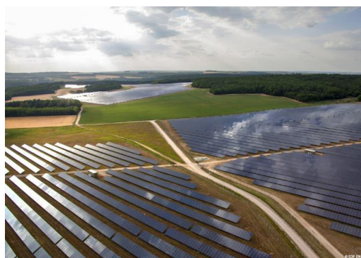
Figure 10 : Pistes de la centrale photovoltaïque de Massangis (source : EDF Renouvelables)
